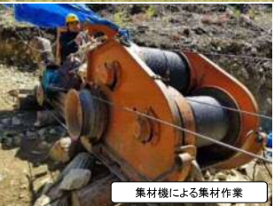
集材機による集材作業
