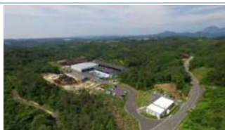
本社及びバイオマス加工施設
