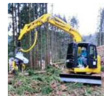
伐採・枝払い作業中
